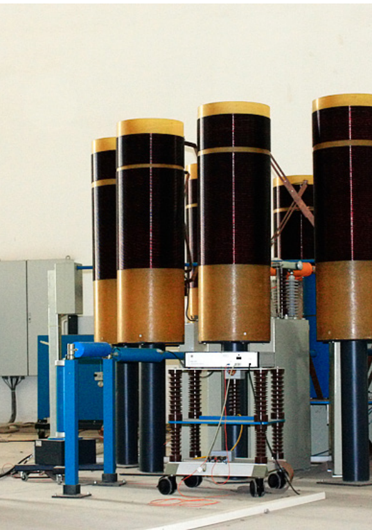
Hệ thống thử nghiệm xung dòng điện để thử nghiệm các thành phần chống sét van theo tiêu chuẩn IEC 60099-4
